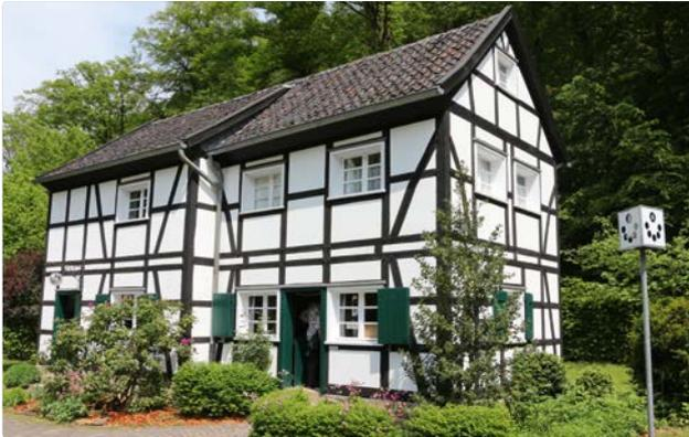
Das ist ein **Fachwerkhaus**. Erkennst du das Gerüst aus Holz? Das ist das Fachwerk. Man sieht Formen. Die Formen machen das Haus stabil. Das Holzgerüst trägt das Gewicht von dem Haus. Die Wände zwischen dem Holzgerüst sind aus Lehm und Stroh.
