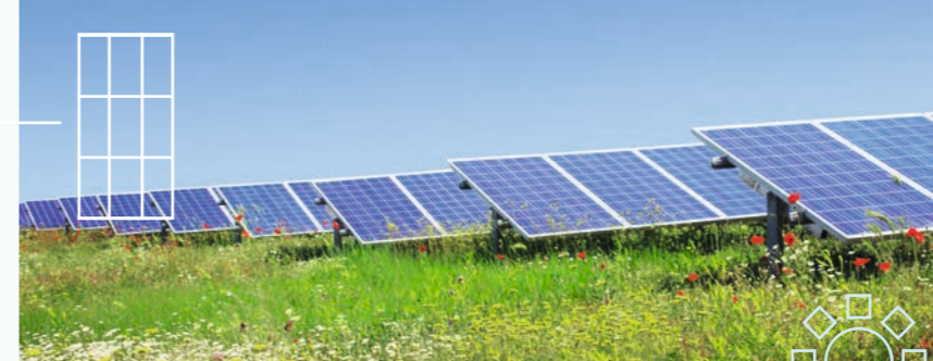
Eine Solaranlage auf einer Blumenwiese.
